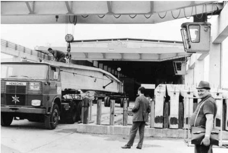
Henschel HS 22 TS der zweiten Generation mit geänderten Scheinwerfern bei der Verladung von Betonbindern im Werk Xanten auf ein Welte Zweiachser-Fabrwerk
